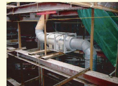
途中で中継し、さらに地下へ給気
