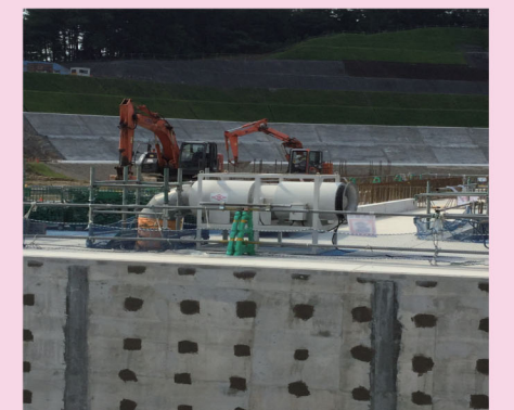
覆工板直下の熱気対策
