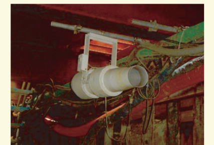
覆工板直下の熱気対策
