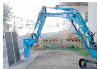
特に不快感を覚える金属打撃音(1k~6kHz)では8~14dB低減し、音質も変わります。
