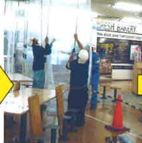
③棒をジャッキアップ
