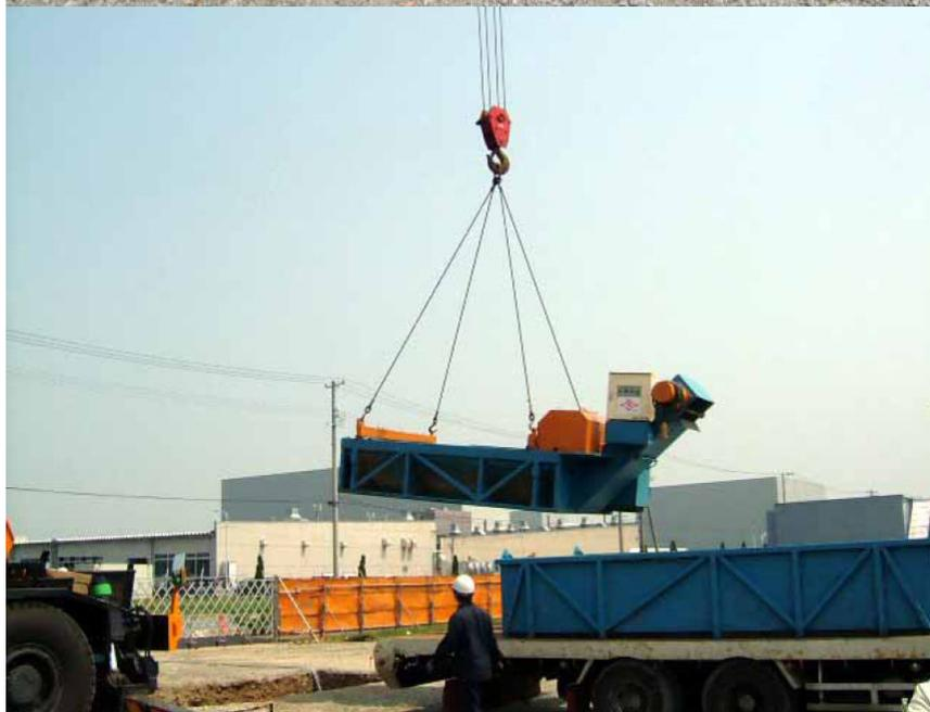
養生後、タイヤ洗浄機用鋼板製簡易ピットを設置。続いて本体を吊荷。
