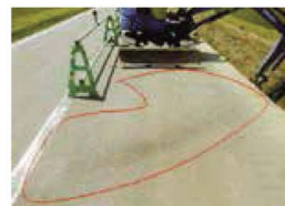
掘削機の作動油のホースが破裂して、舗装の上に漏れている油の処理
