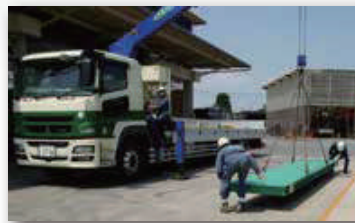
クレーン不要。ユニック車で設置できます。
